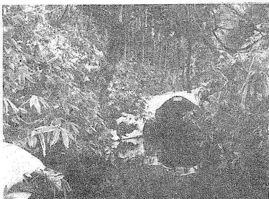
写真-1 現穴堰（出口）撮影：伊藤、1990.12.1
