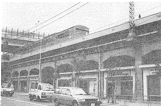
写-7 野田駅付近の高架橋
