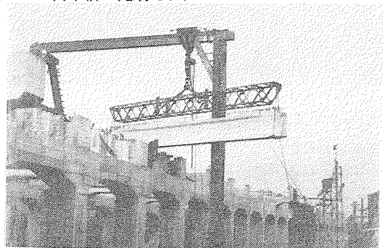
写-8 野田駅付近グライアスでの高架橋建設 (芦田和治氏所蔵) 1963
