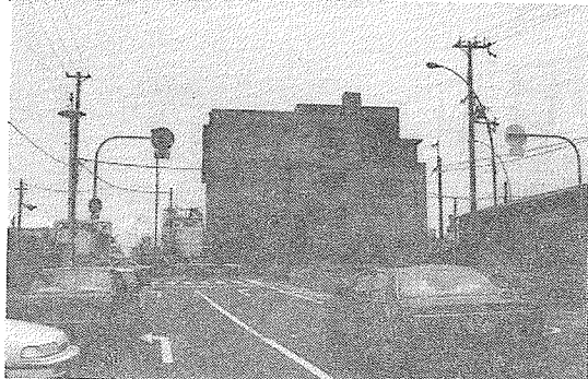
写-4 安治川海底トンネル（西九条駅側）
