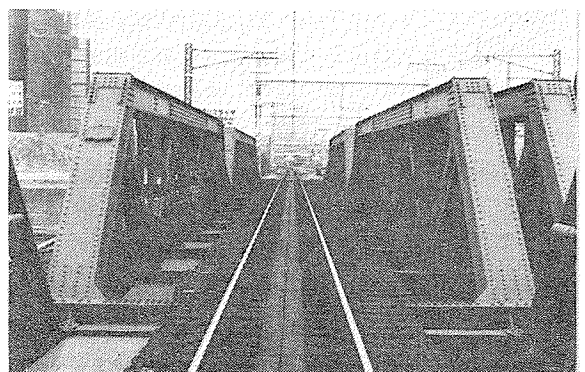
写真6 上神崎川橋梁 E45ポニーワーレントラス 1912 American Bridge 製作 1991年撮影 (JR西日本)
