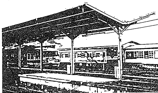
写真-4 上り線ホーム上屋
