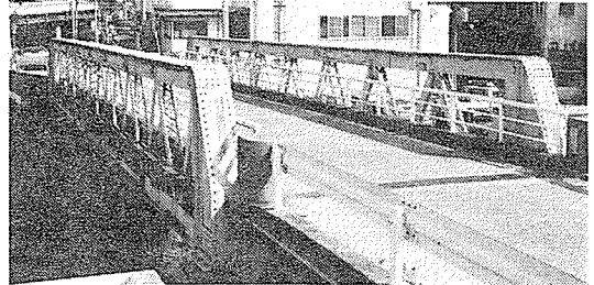
写真1 現存するわが国最初の鉄道用鉄桁。浜中津橋 (大阪市大淀区、旧長柄運河) (1987.6)
