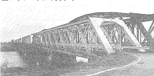
写真7 錬鉄製 200ftダブルワーレントラス 沢渡橋 (1983.12)
