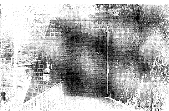
写－14 草山トンネル入口方坑門 [1989] 大正期に延伸した坑門で断面は側壁が垂直。
