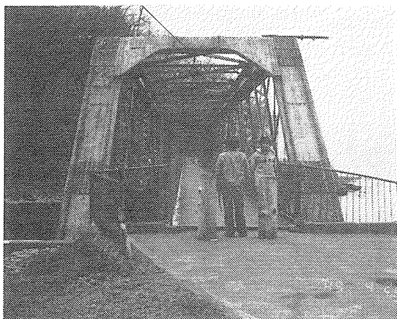
写真-2 湖畔橋正面
