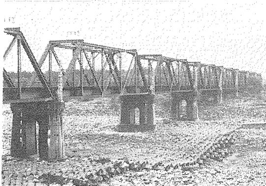
写真 4 大糸線高瀬川橋梁。筑豊本線遠賀川発生 (1986) のPatent Shaft製100ft桁8連。1958架設。
