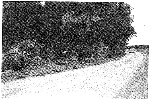
写真- 1 流下物による障壁の例
