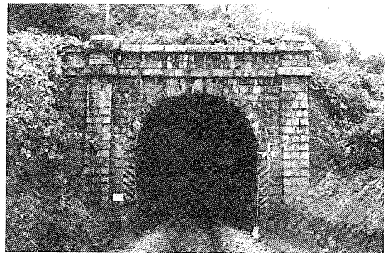
写-7 鳥ヶ原トンネル湊町方坑門[1987] この区間のトンネルは石材が多用されている。
