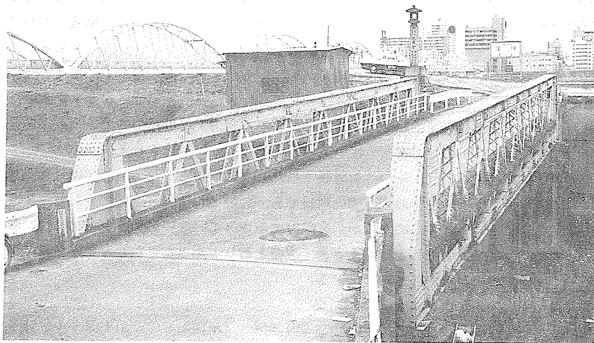
写真2 浜中津橋全景，右が上流方，向こうは淀川（1987. 1）。
