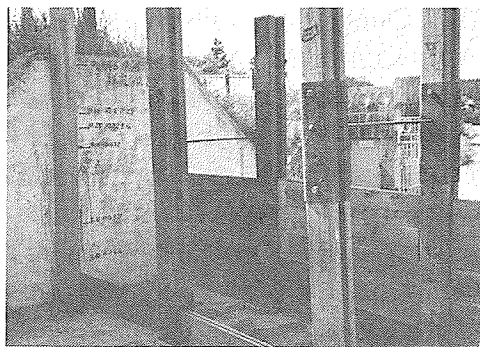
写真-6 止水板組立状況 (撮影：水戸市水道部, 1983. 12. 13)
