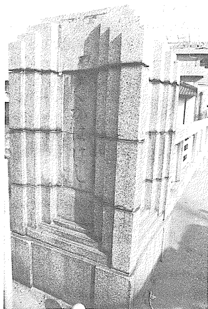
図-3 モダンムーブメントの影響がみられる 貢川橋の親柱
