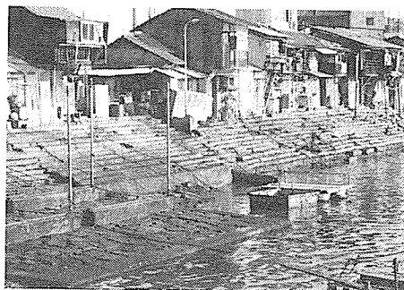
写真-1 尾道港：石積雁木（1981年撮影）
