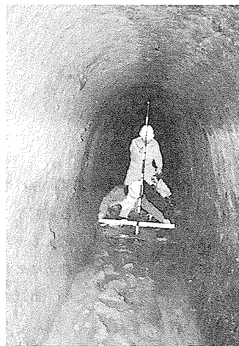
写真・2 疎水トンネル断面現況
