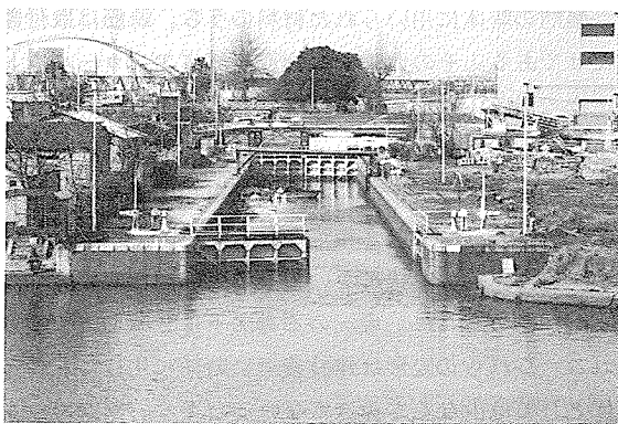
写真-2 下流側正面現況（解体直前）
