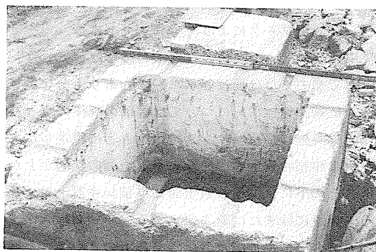
写真-12 閘室部のコンクリート井筒最下段
