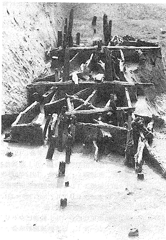
写真-1 木製遺構の全容（北から南を見る。川は右から左へ流れている。）
