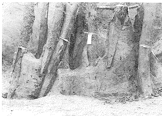
写真-7 杭先の形と打止め位置
