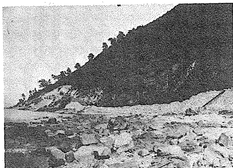
写真 3. 山を崩し、石垣を築いているところ。
