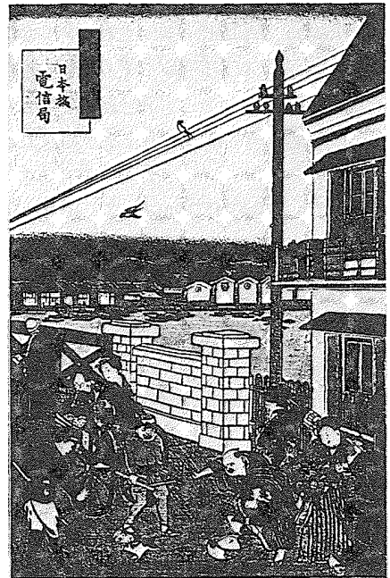
図-1 日本橋の電信柱と電線
