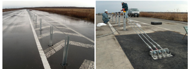
写真-9 直線区間の支柱（左）と末端部施工状況（右）
