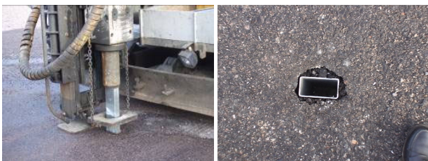
写真-7 スリーブ管施工機械（左）と施工後の状況（右）
