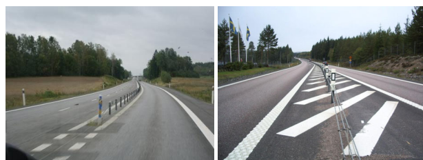
写真-2 ワイヤーロープ式防護柵付きの2+1車線道路(スウェーデン)
