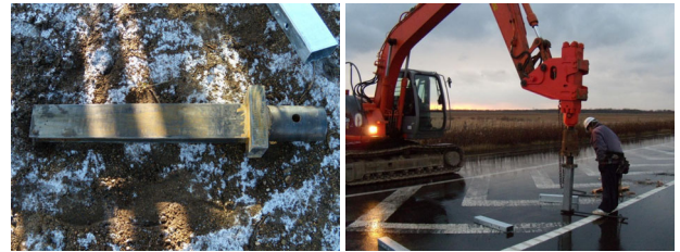
写真-8 作成したアタッチメント（左）と施工状況（右）
