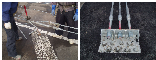
写真-11 ターンバックルによるワイヤーロープ緊張作業（左）と末端のアンカーブラケット（右）
