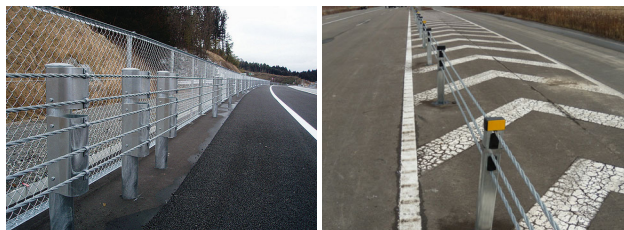
写真-3 ガードケーブル（左）とワイヤーロープ式防護柵（右）
