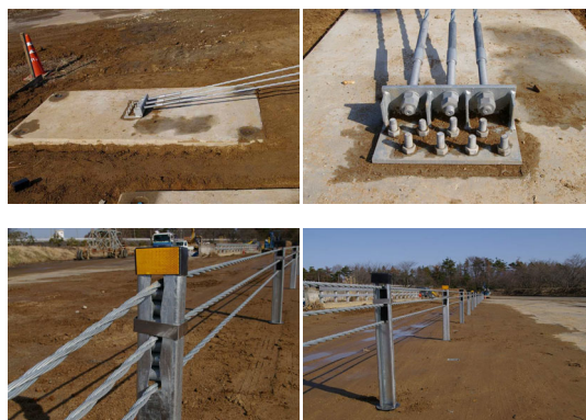
写真-12 ワイヤーロープ式防護柵の供試体設置状況
