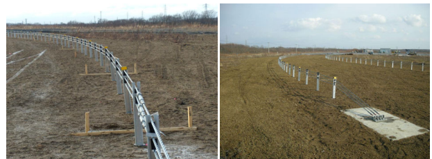
写真-10 カーブ区間の施工中（左）と施工後（右）の状況
