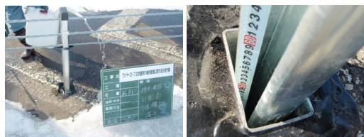
写真-16 スリーブ管内の浸水試験状況
