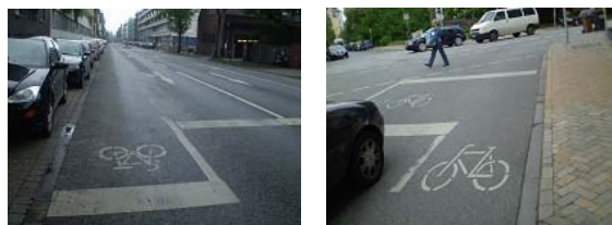
写真－３ 交差点手前における自転車への配慮
