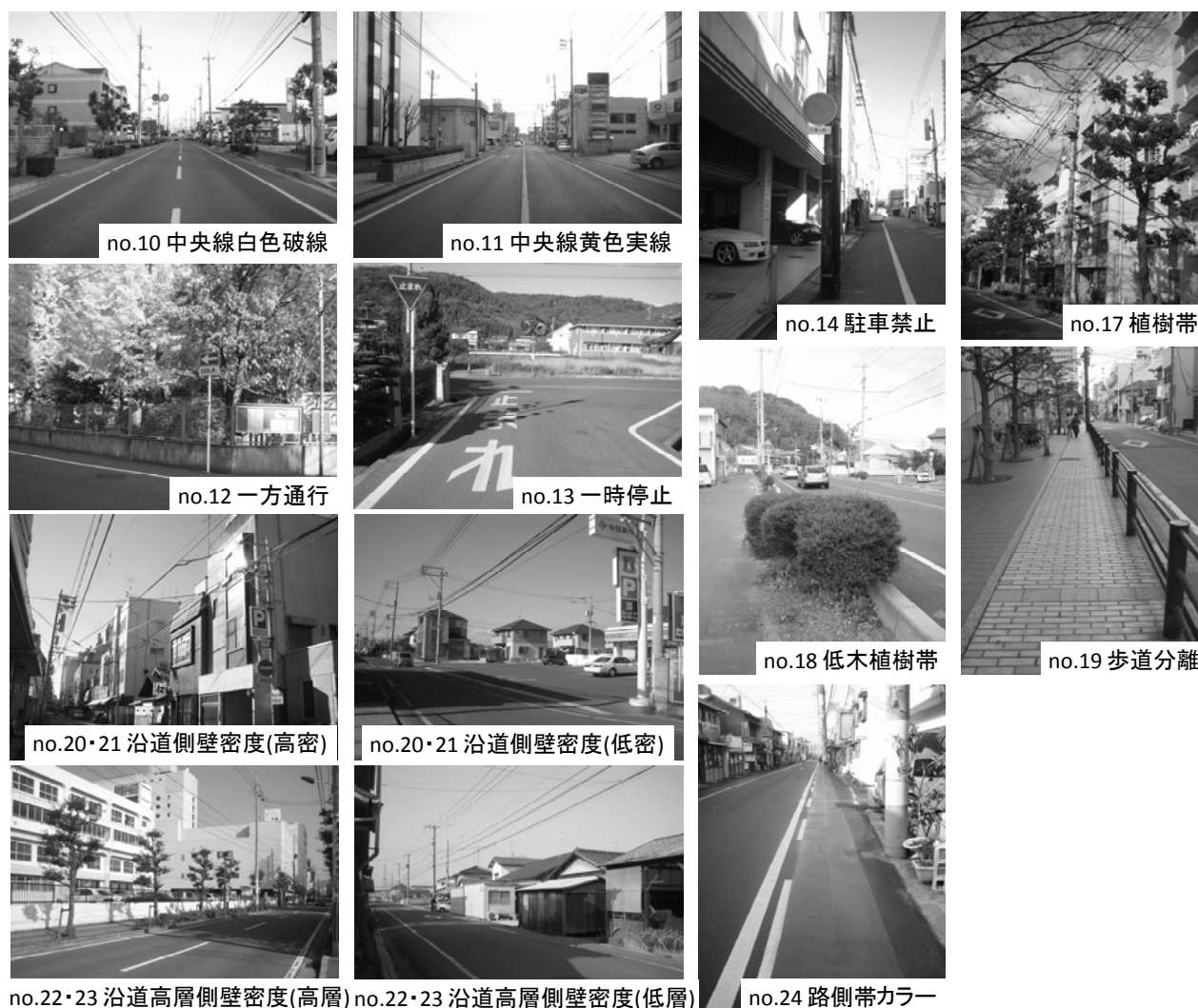
図6 道路構成・沿道状況の例
