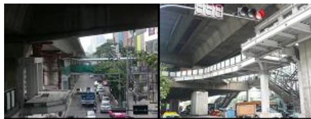
図10 高架駅でのSky-Bridgeの設置
