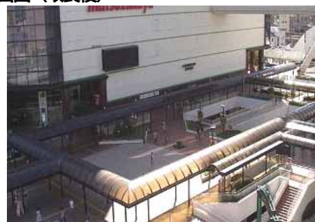
写真-1 改良前のデッキ (左下名鉄「豊田市駅」側、右上愛環「新豊田駅」側)
