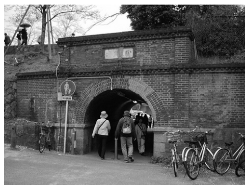
図-8 インクライン下の「人行隧道」
