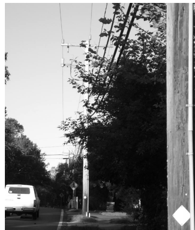
写真-5 電力会社管理の電線が州管理の街路樹及び民地の樹木と干渉している状況(筆者撮影)
