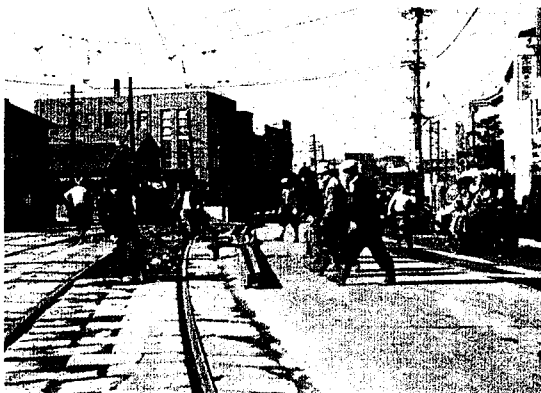
写真-8 レールの補修作業の様子：1956年 25)
