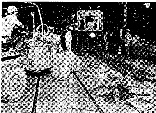
写真-17 北方線の撤去の様子：1980年 35)
