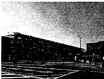
写真-5 JR岐阜駅 (駅前には都心居住を謳う超構想ビル +集合住宅が建設中: 筆者撮影)
