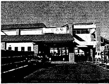
写真-7 忠節駅 (郊外の主要幹線からも外れた駅舎 のみが残る：筆者撮影)
