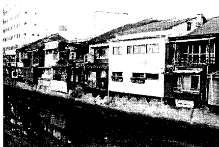
写真-3 博多川沿いに張り出した建築物 （出典：博多川夢回廊構想）
