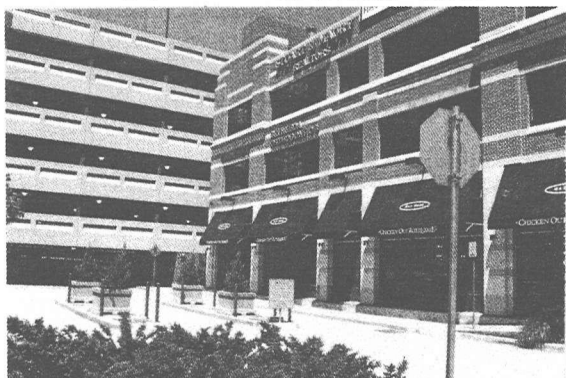
図-3 ベセスダ通り開発 (一括型駐車施設：左側建物)
