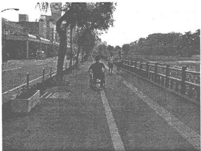
写真－3 縦断勾配の連続する歩道
