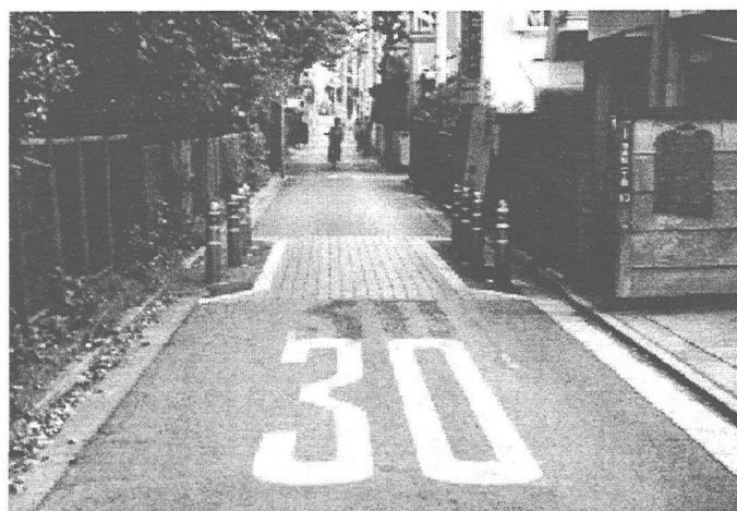
図9 市境道路に設置された狭窄
