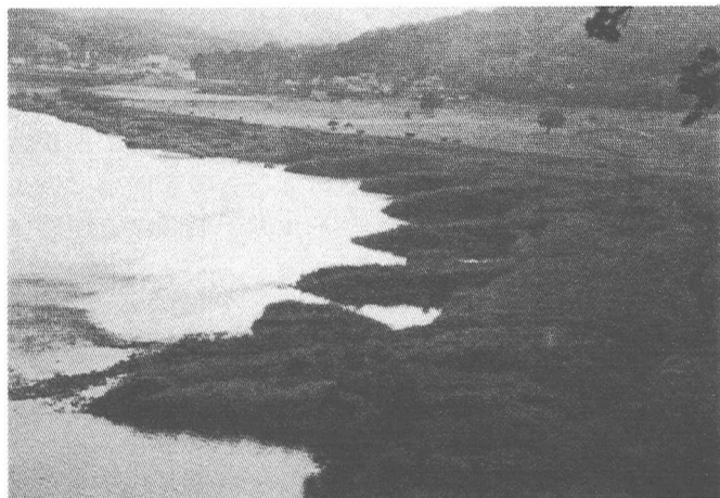
写真-2 水制及び堆積した微地形による平面秩序 (大野川)
