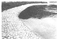
写真-15 自然石を張った事例 （「共和コンクリート工業資料」より）
