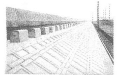
写真-6 張ブロック (「共和コンクリート工業資料」より)
