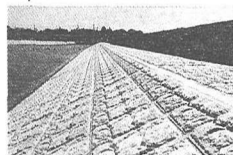
写真-16 擬石模様を施した事例 （「三菱セメント建材資料」より）
