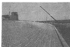
写真-21 覆土ブロック (東京都荒川、左：施工中、右：施工後)
