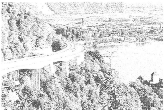
写真－1 道路整備事例
