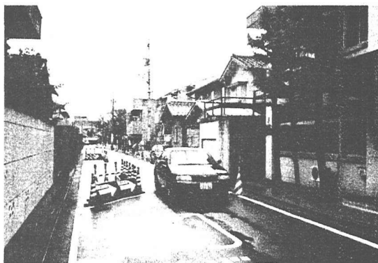
写真-1 シケインによる整備
