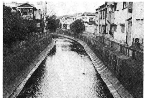
写-5 栄橋～伏見橋間 昭和62年
