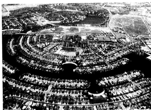
写真一 3 サンフランシスコ・フォスターシティ (堀込式、湾の入口に水門)
