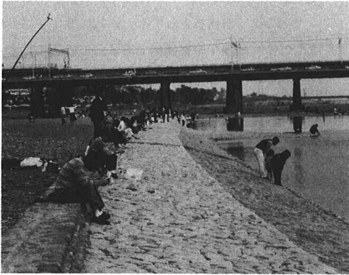
写-9 河川風景主義の考えに近い護岸整備例
