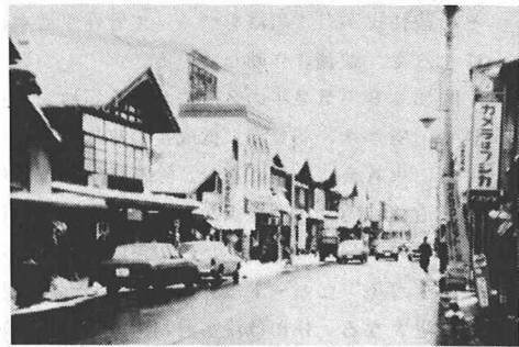
写真2：流雪溝ができたあとの豪雪時（昭和56年1月）の上と同じ位置（積雪深3.5mの時）
