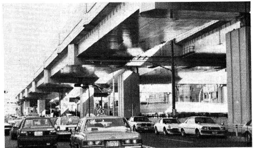
写真-15 横浜 堀川筋。水際線橋脚、横梁張出、橋脚目地、桁裏処理。
