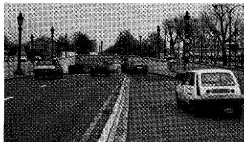
写真-7 パリ V.G.P. コンコルド広場アンダーパス部、一般街路（右側）からの流入部
