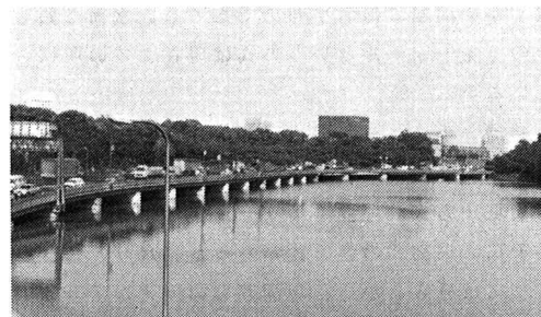
写真-11 千鳥ヶ淵。水上橋脚低位高架。
