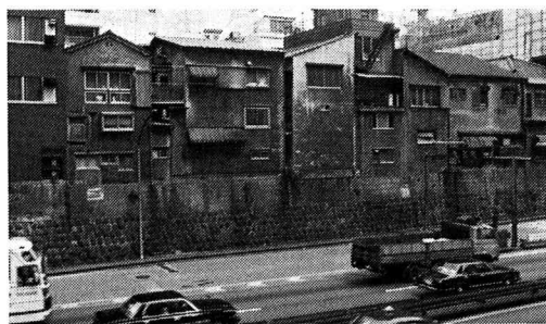
写真-16 東京 築地川、楓川の部分。掘削構造。 この部分では旧護岸が保存されている。
