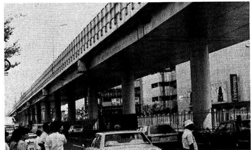
写真-18 大阪 千日前。大きなクリアランス、桁裏化粧板により明るくすっきりとしている。
