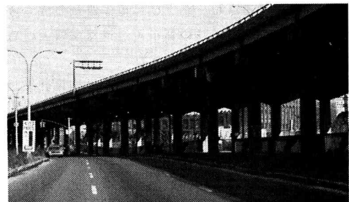
写真-3 Bruckner Expressway (1963-66) 高架部
