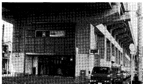
写真-6 阪神高速道路松原線。上が都市高速、地下が地下鉄、正面は地下鉄駅舎部分。
