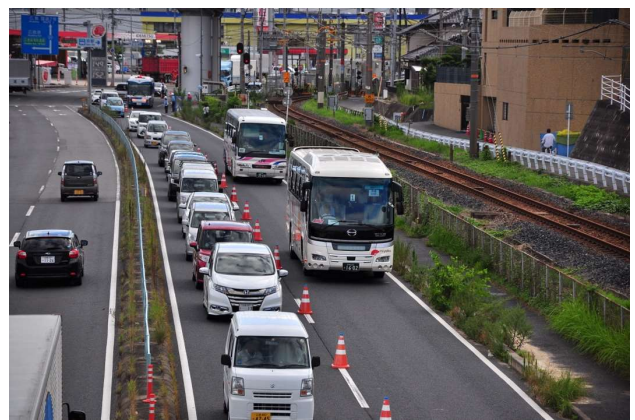
図3 バス・災害関係車両等専用レーンの様子 （道交法規制によるバス専用レーンの運用前）
