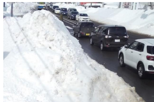
写真-1 路肩堆雪による道路有効幅員の減少
