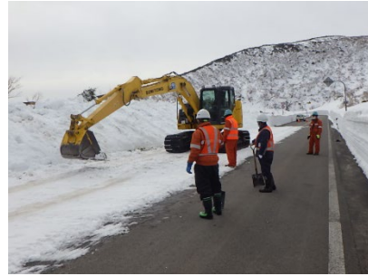
(b) 道路への敷き均し
