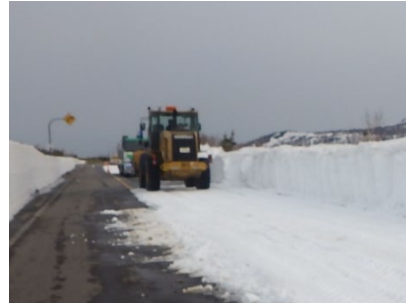
(c) 実験路（圧雪路面）の作成
