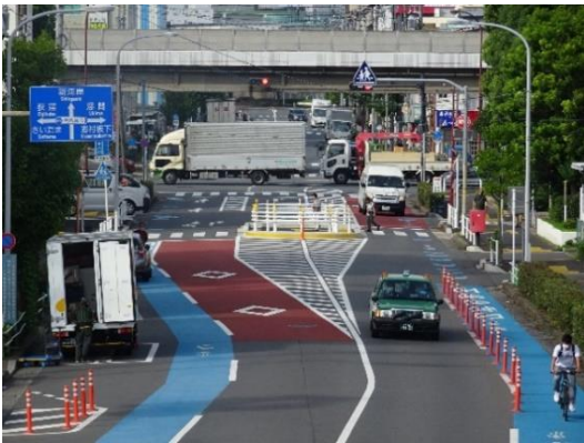
図-5 整備後の状況（南から北方向を臨む）
