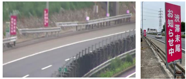
図-9 設置1箇所あたりの全景 (左)
