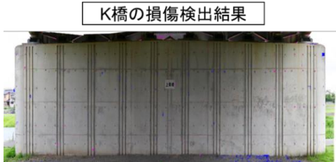
図-5 橋脚の全体画像に対する損傷検出結果
