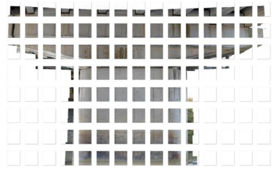
図-6 分割した橋脚画像
