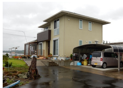
図 11. 住宅部分のみ嵩上げた住宅
