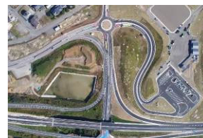
(g) 自専道接続型 (長野県飯田市)
