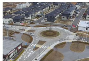
(c) 住宅地区型 (愛知県岡崎市)
