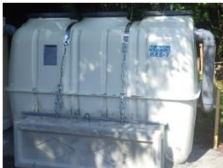
図-14 小水路に設置した一般普及型浄化槽
