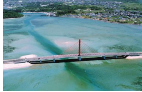
図-5 平安座南第1航路の浚渫工事
